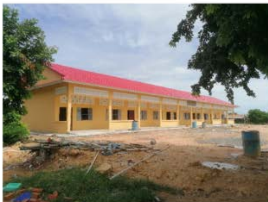
Escola de nova construcció
