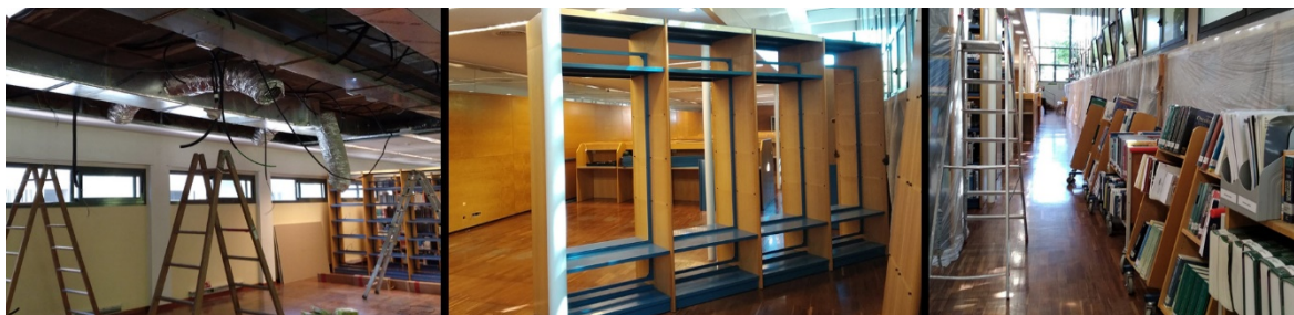
Figura 4. Tasques d'execució d'obres.
